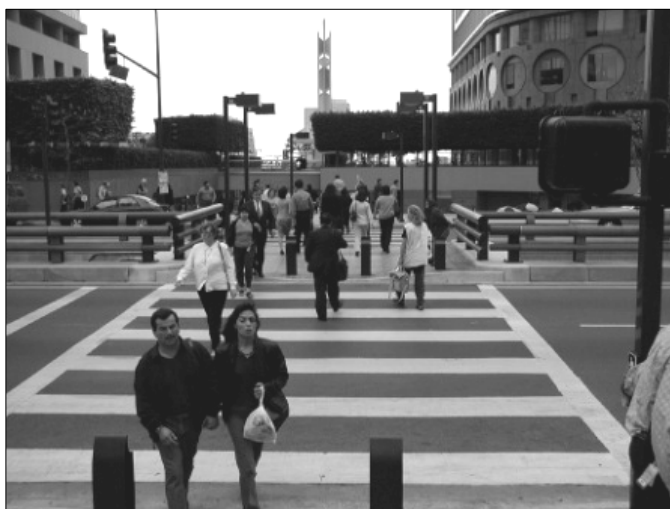
Figura 5.13: Travessia de pedestres canalizada por barreiras em Los Angeles, Estados Unidos (Fonte: PBIC, 2005).
