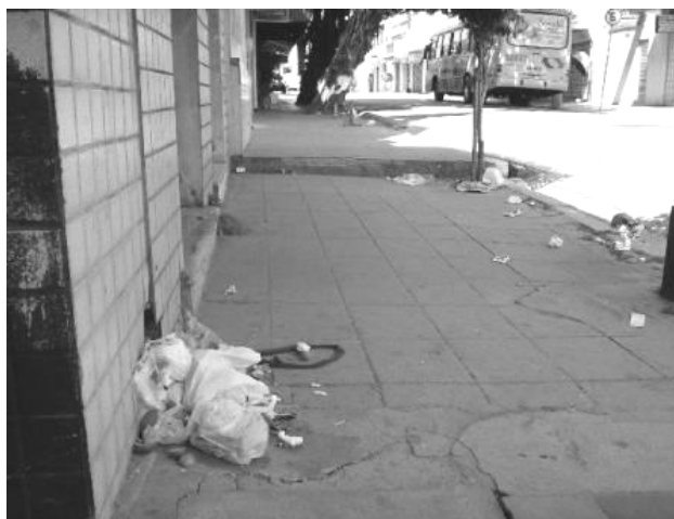
Figura 3.4: Degrau impedindo a continuidade do passeio no Centro de Fortaleza-CE (2005).
