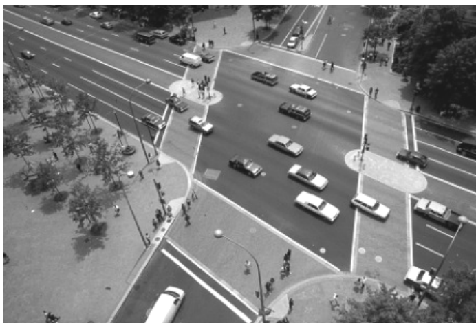
Figura 5.8: Cruzamento concebido para travessia segura de pedestres na Pensilvânia, Estados Unidos (Fonte: PBIC, 2005).
