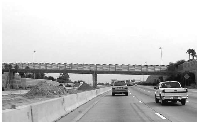
Figura 5.9: Passarela sobre rodovia de trânsito rápido no Arizona (Fonte: PBIC, 2005).
