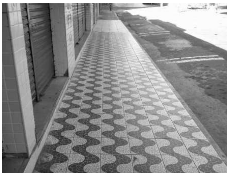
Figura 3.7: Utilização de material derrapante como superfície da calçada no Centro de Fortaleza-CE (2005).
