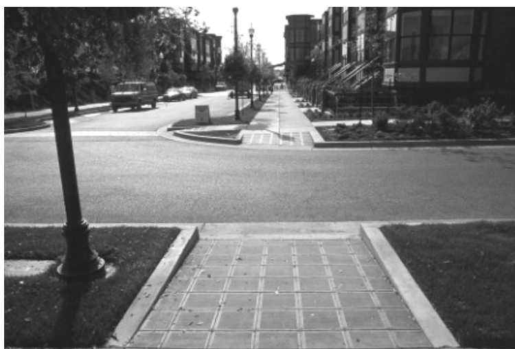
Figura 5.7: Rampa em área de travessia com superfície tátil para auxílio aos portadores de necessidades especiais de locomoção (Fonte: ZEGEER et al. , 2002).
