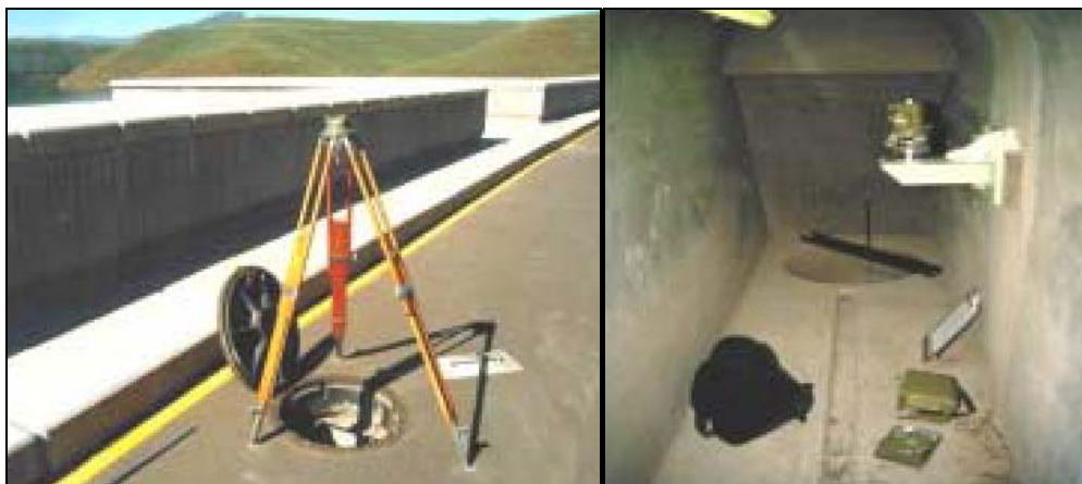
FIGURA 24 - ALINHAMENTO ÓPTICO PARA LIGAÇÃO DA POLIGONAL À REDE GEODÉSICA
