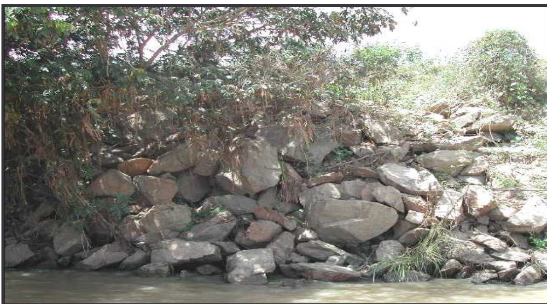
Figura 5.7 – Fotografia mostrando o enrocamento implantado ao longo da margem direita do rio São Francisco. Fonte: Bandeira 2005
