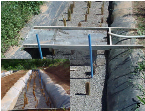
Figuras 1 a 6 – Visão parcial do sistema “wetland”, evidenciando os tanques (1), brita como substrato e impermeabilização com lona butílica (2), tanque armazenador de dejetos (3), tubulação que leva o dejetos (4), tanque com Typha latifolia recém plantada (5) e dejetos chegando no tratamento 1 sendo peneirado (6).
