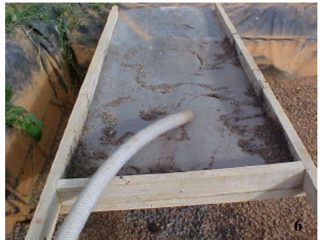
Figuras 1 a 6 – Visão parcial do sistema “wetland”, evidenciando os tanques (1), brita como substrato e impermeabilização com lona butílica (2), tanque armazenador de dejetos (3), tubulação que leva o dejetos (4), tanque com Typha latifolia recém plantada (5) e dejetos chegando no tratamento 1 sendo peneirado (6).
