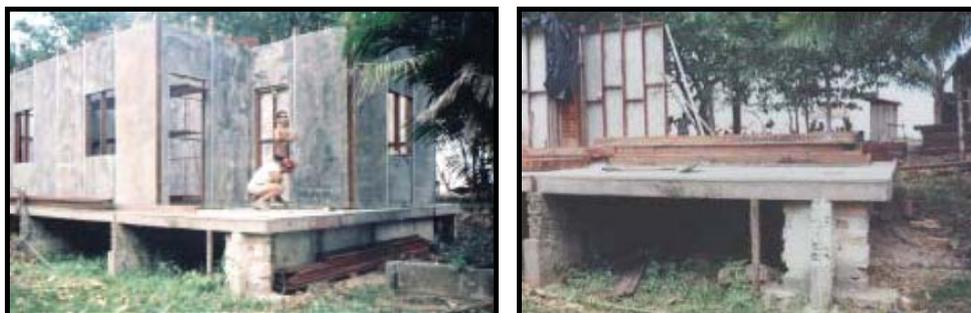
Figura 2.24 – Painéis sendo erguidos sobre a fundação.
