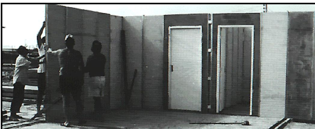
Figura 2.21 – Edificação em painéis ICOMA.
