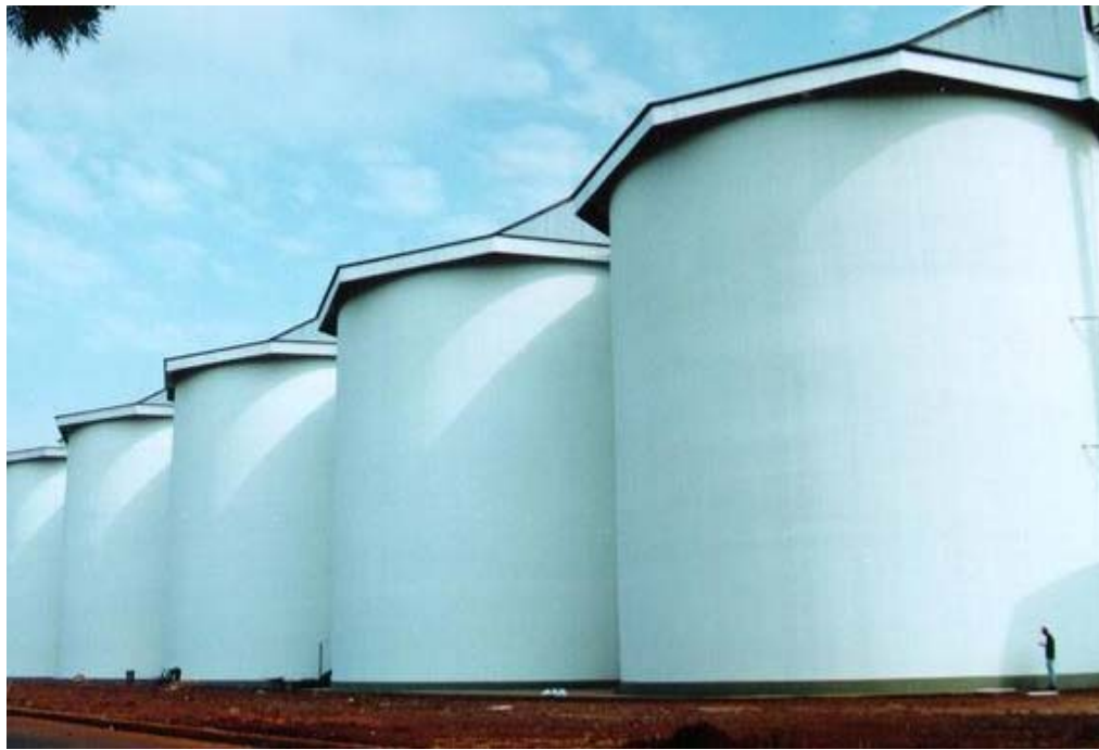
Figura 2.1 - Silos de Concreto
