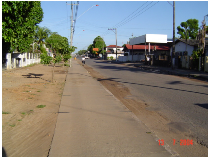
Figura 5.3 - Calçada na avenida Mário Homem de Mello com 2,00 m de largura efetiva.
