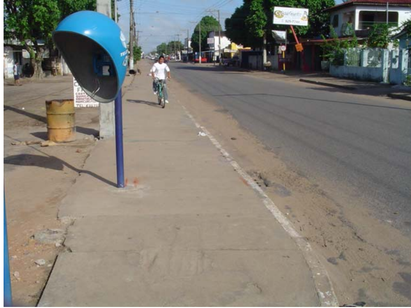
Figura 5.4 - Calçada na avenida Mário Homem de Mello com 1,55 m de largura efetiva.
