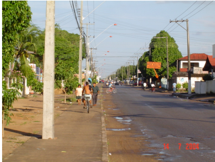
Figura 3.11 - Conflito entre ciclistas e pedestres sobre a calçada
