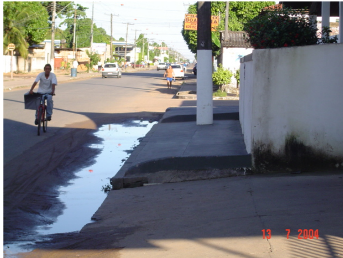
Figura 3.2- Falta de drenagem afastando o ciclista para o meio da rua
