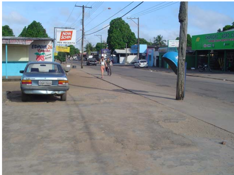
Figura 5.5 - Calçada na avenida Mário Homem de Mello com 0,90 m de largura efetiva.
