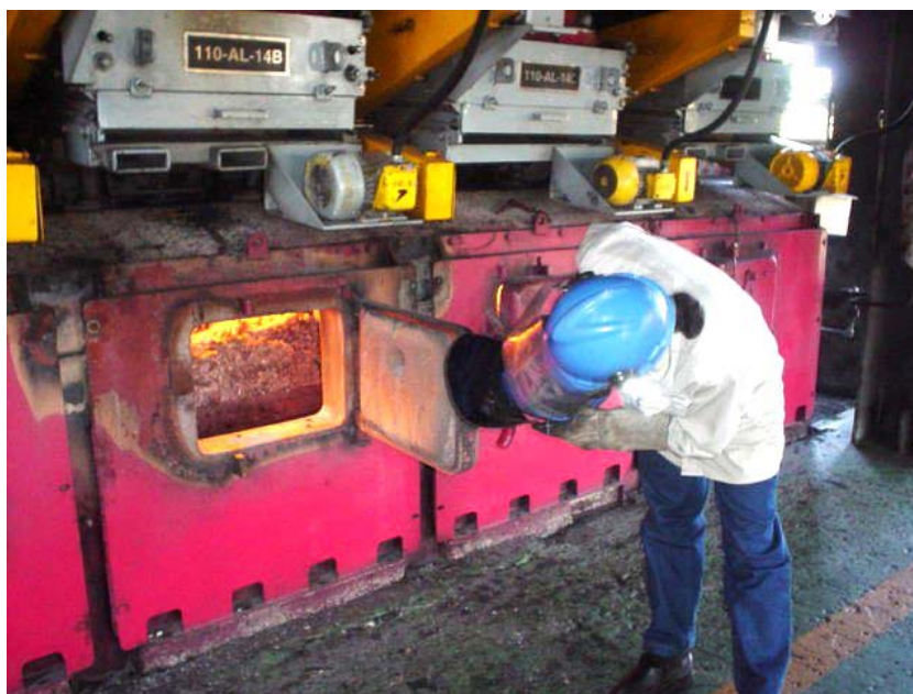
Treinanda do PFO em atividade nas caldeiras
