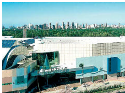
Figura 2.15 – Shopping Center Iguatemi, Fortaleza, CE Fonte: ABRASCE, 2004.
