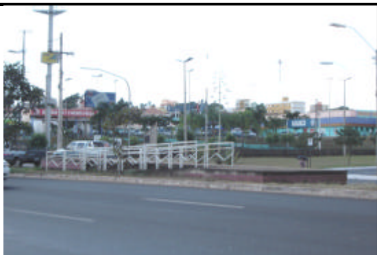
Figura 3.11 – Av. João Naves de Ávila, parada para ônibus em nível
