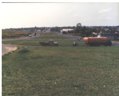
Figura 4.20 – Av. João Naves- sentido bairro (1989) Fonte: SETTRAN (1989)
