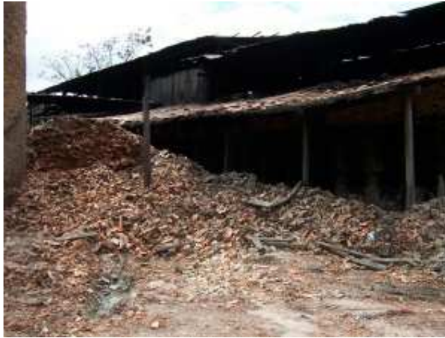
FIG.5.5 Detalhe de depósito de cacos cerâmicos para uso em pavimentação.
