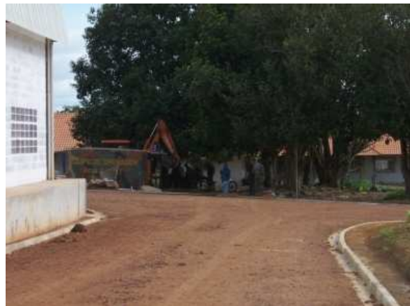
FIG.5.7 Trecho de pavimentação urbana sendo executado pelo 8º BECnst.
