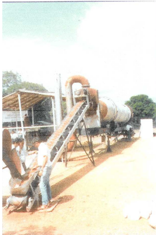
FIG.2.9 Saída da argila pelletizada para a correia que alimenta o forno rotativo (Relatório do Convênio MT/UFAM, 2004).
