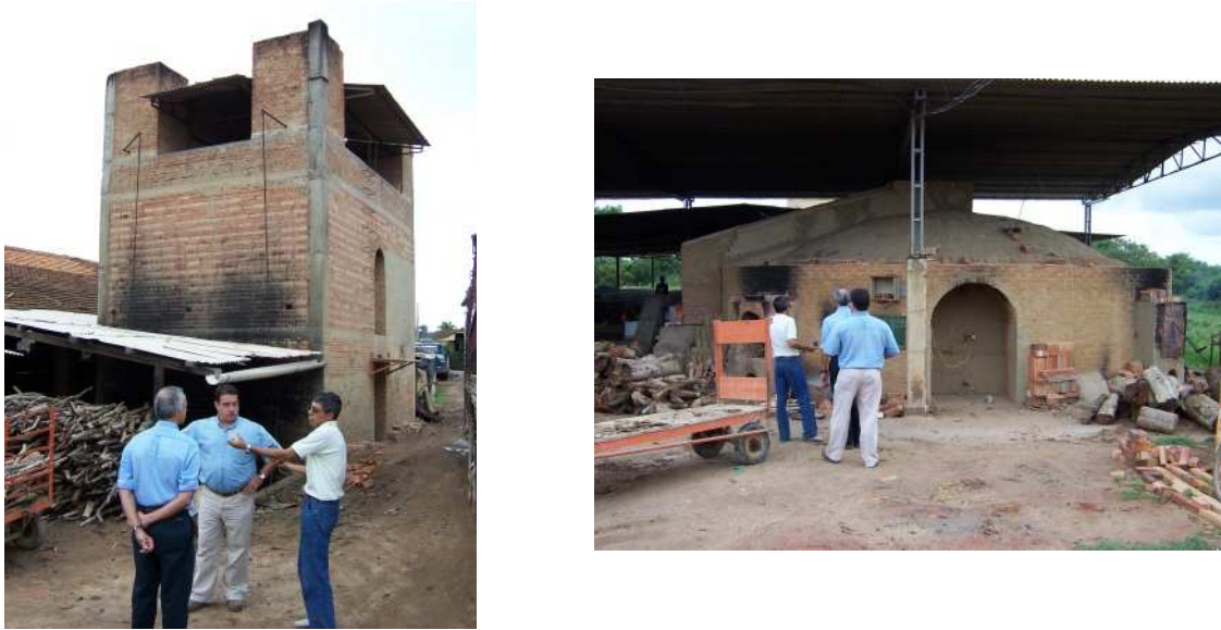
FIG.3.46 Vista geral do forno tipo caieira para tijolos (esquerda) e do tipo abóbada para telhas.
