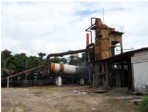
FIG.5.6 Usina de asfalto do 8º BECnst para confecção do AAUQ.
