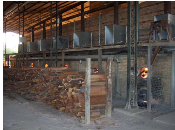
FIG.5.33 Detalhe da lenha empregada como combustível e da instalação do novo sistema de queima (acima).
