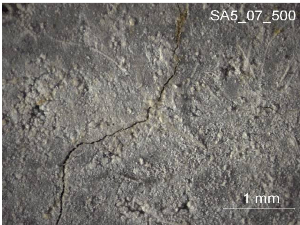
Figura 5.27 Fissuras no corpo-de-prova formulação SA5 na idade de 500 ciclos.
