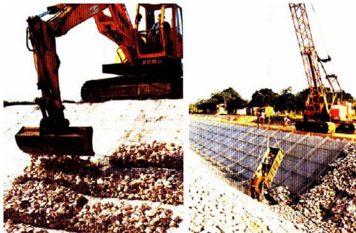
FIG 5.5 - Proteção Direta – Colchão Reno – Enchimento do colchão Reno na obra Fonte: MACCAFERRI, 2002
