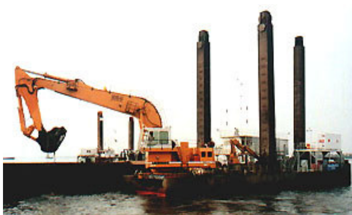
FIG 5.18 - Dragagem Escavadeira Ambiorix pertencente à Ballast Ham Dredging
