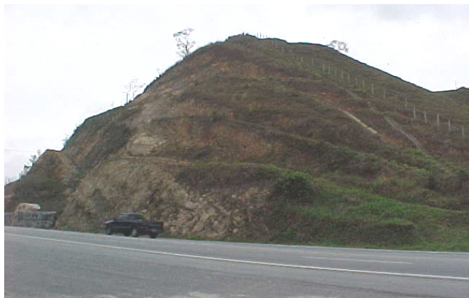
FIG.5.25 Estaca 119 A 123 da Rodovia RJ-124 (Ponto DS2) Fonte: VIA LAGOS (2001)
