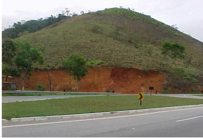
FIG.5.24 Estaca 90 da Rodovia RJ-124 (Ponto DS1) Fonte: VIA LAGOS (2001)
