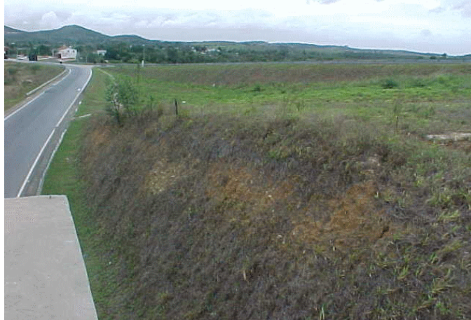
FIG.5.26 Interseção entre RJ-124 e RJ-106 (Ponto DS2)
