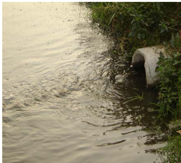
Figura 16 - Local de amostragem do efluente que sai da lagoa de tratamento 2 e entra na lagoa de tratamento 3
