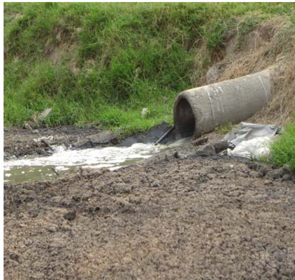
Figura 12 - Local de amostragem do efluente que sai do tanque de decantação e chega à lagoa de tratamento 1
