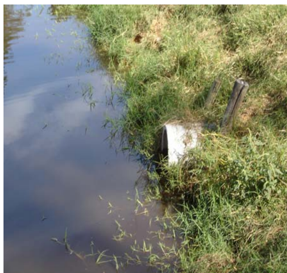
Figura 22 - Local de amostragem do efluente que sai da lagoa de tratamento 5 e entra na lagoa de tratamento 6
