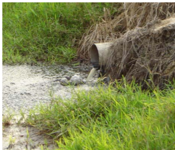
Figura 14 - Local de amostragem do efluente que sai da lagoa de tratamento 1 e entra na lagoa de tratamento 2
