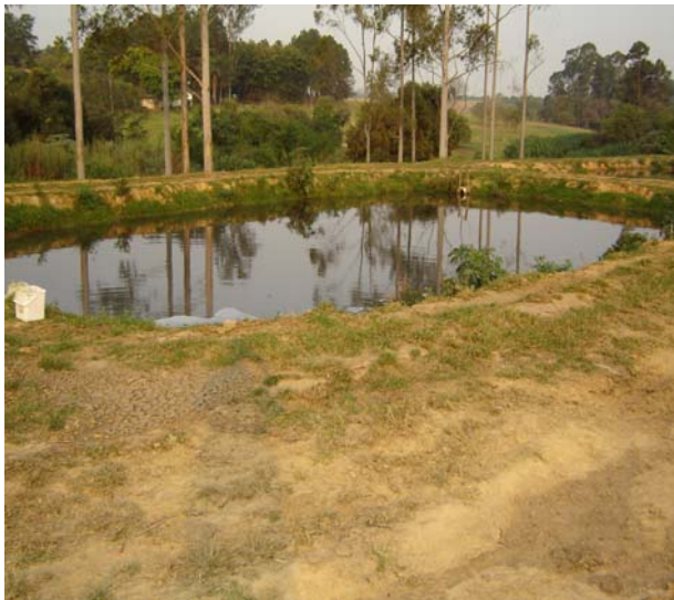
Figura 19 - Lagoa de tratamento 4
