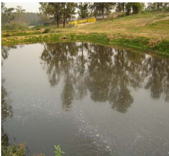
Figura 17 - Lagoa de tratamento 3
