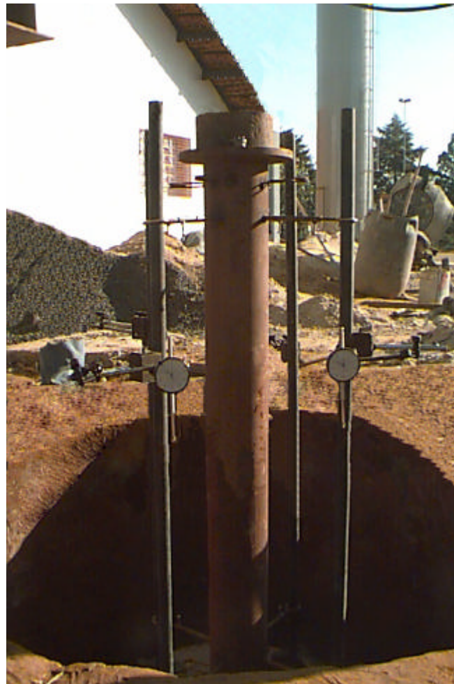
Figura 3.15 – Torre de transferência de carga
