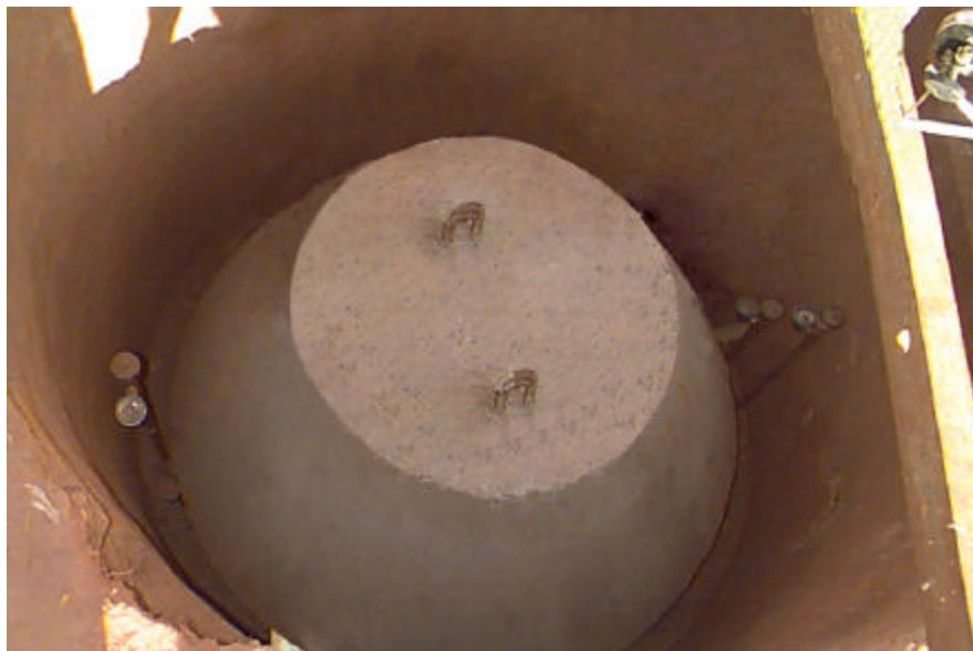
Figura 3.14 – Sapata de concreto armado de 1,50 m de diâmetro
