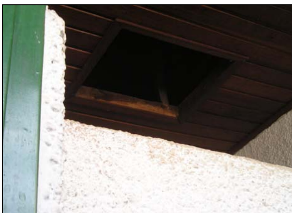
Foto 16: Abertura do forro no banheiro masculino
