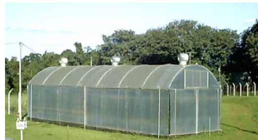
Figura 4 – Vista de casa de enraizamento (estufa)
