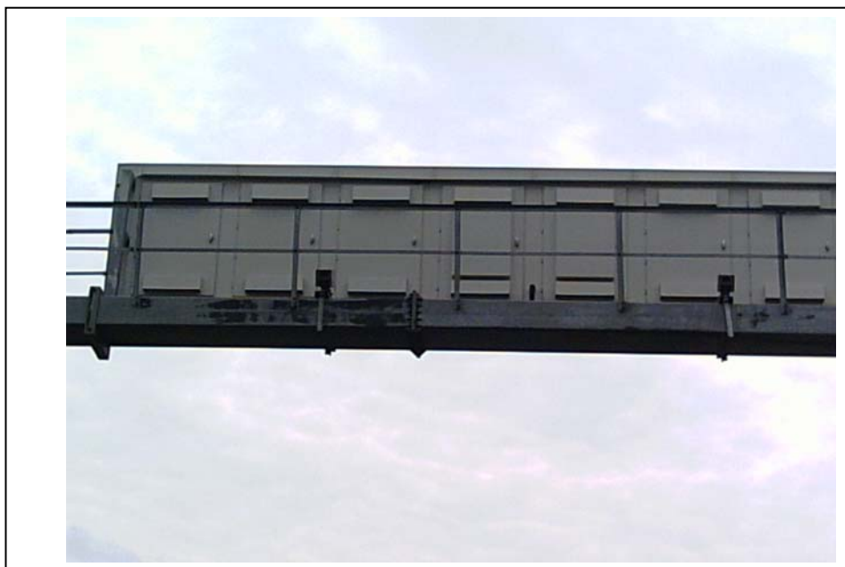
Figura 3.5 - Foto do detalhe da fixação dos radares no passadiço do pórtico.
