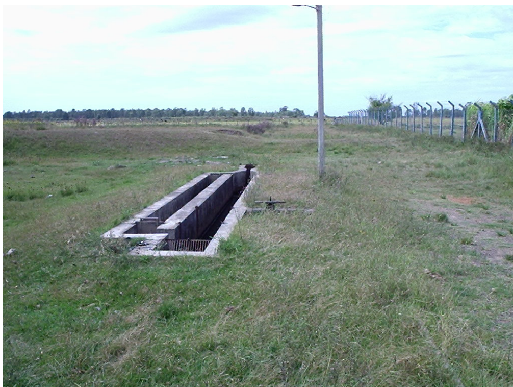
Figura 4 - Gradeamento, caixa de areia, e calha Parshal
