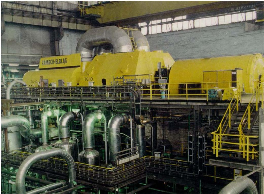
Figura 3.11 – Turbogenerador
