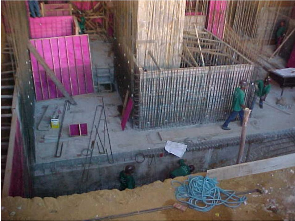
Figura 1.1 – Construção de fundação de máquina
