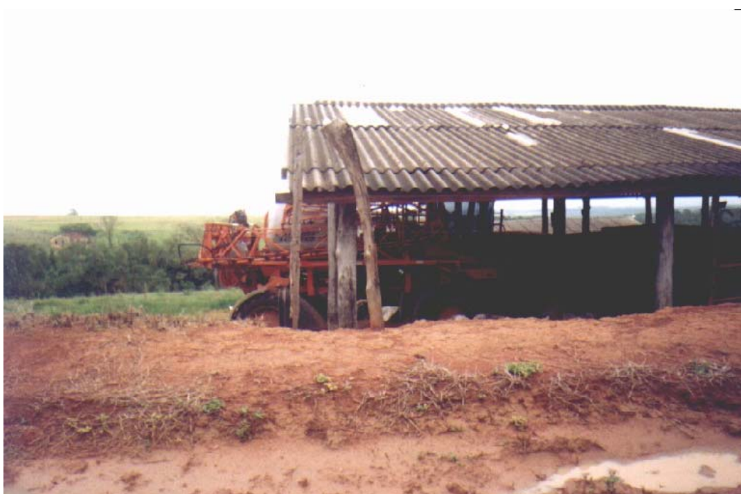
FIGURA 23 – Uberaba-MG – Instalações do Arrendatário na Terra Arrendada - As instalações são precárias, pois os investimentos do arrendatário não serão ressarcidos pelo proprietário das terras. Os barracões são construídos em lugares em que não se pode trabalhar a terra, no caso, próximo às áreas de veredas a serem obrigatoriamente preservadas. AUTOR: MARIA, L. X.: 2004.
