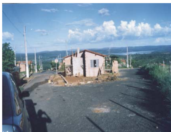
Figura 32 - Construção em área destinada a rotatória no Parque das Brisas. OLIVEIRA, L.V.A
