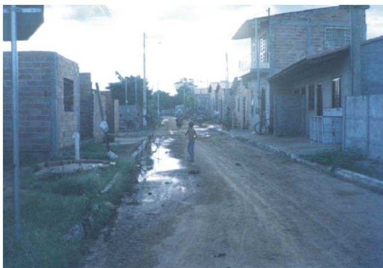
Figura 15 – Rua 7 (sem saída) no Lago das Brisas. Local ainda desprovido de rede de esgotos. OLIVEIRA, L.V.A. Abril 2003.
