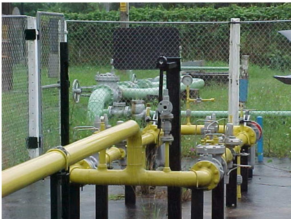
**Figura 4.1 ERPM Típica**
