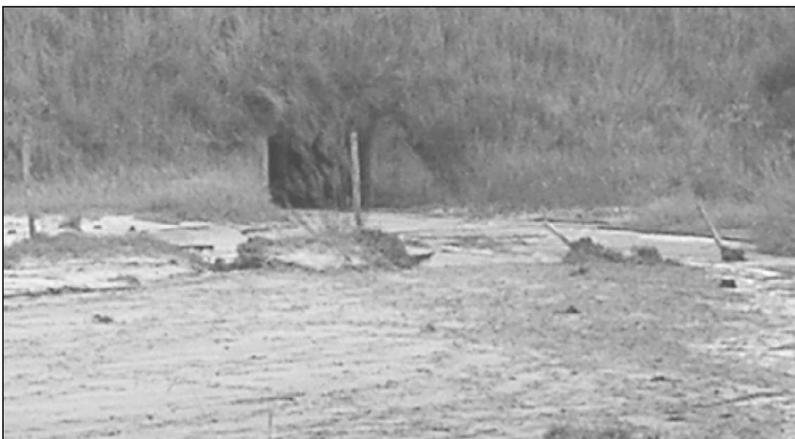
Figura 36: Duto abaixo da estrada e deposição do material retirado das cabeceiras de drenagem.
