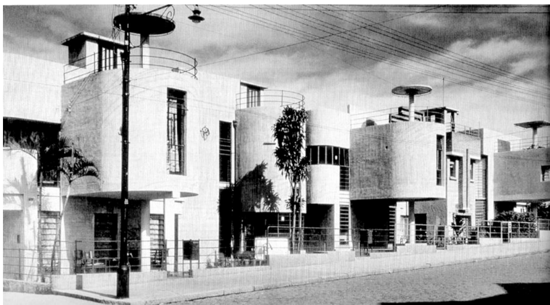
Figura 08 - Conjunto das casas da Alameda Lorena. São Paulo. 1936. Arquivo J. Toledo. Fonte: OSÓRIO. 2000. p. 34.
