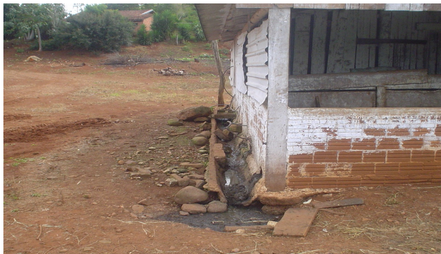
Figura 14 - Pocilga sem sistema de retenção dos dejetos, interceptando água do telhado e do pátio nos dias de chuva.
