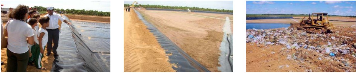
Figura 2-3 – Vistas do aterro sanitário de Ceará-Mirim (Fonte: Urbana, 2005)
