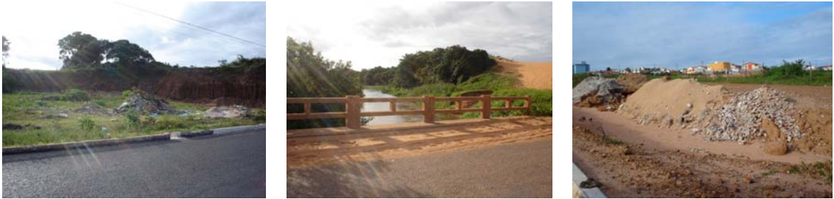
Figura 2-4 – Lançamento de RCD às margens do Rio Pitimbú (Fonte: Silva Filho, 2005)
