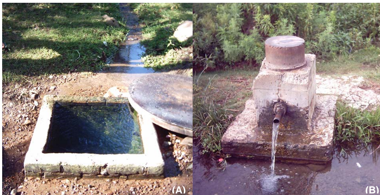
Figura 6 – Exemplo de nível estático zero nos poços surgente, em Quaraí, BR (A) e jorrante em Artigas, UY (B).
