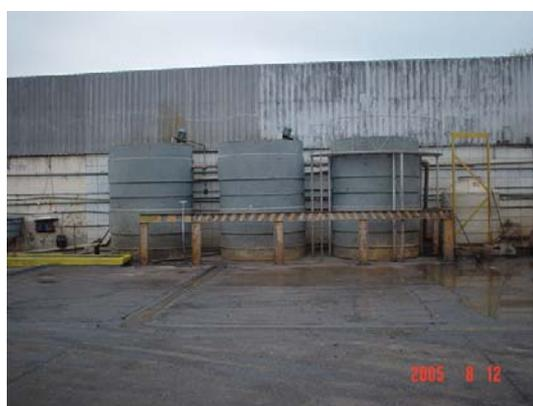
Figura 36. Reator Lodos ativados/
