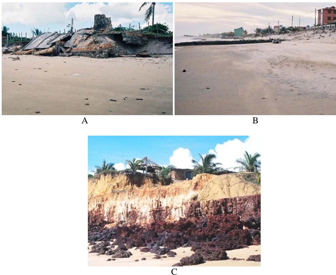
Figura 50 – Ocupações em locais inadequados na orla da Costa das Baleias. A – ruínas de uma propriedade encontrada na margem sul do rio Peruípe; B – obras de engenharia construídas na praia de Mucuri; C – Casa localizada na borda da falésia, na localidade de Costa Dourada, orla do município de Mucuri (ver figura 41 para localização).
