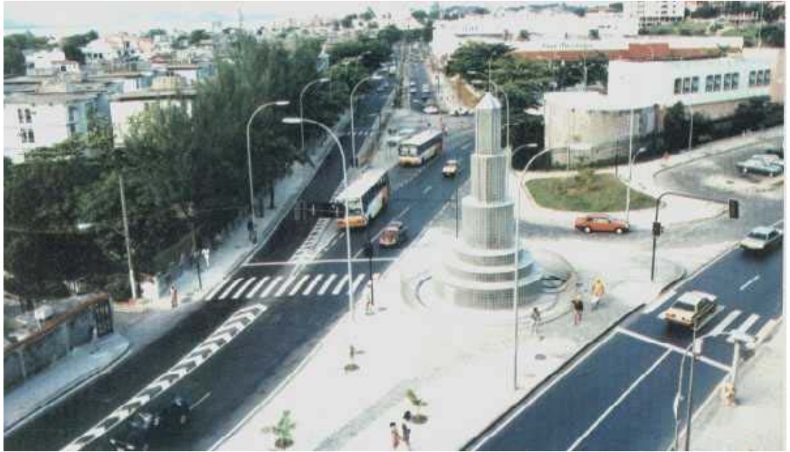
Foto 9 - Detalhe da Estrada do Galeão após as obras
