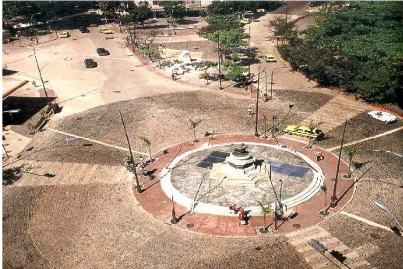
Foto 3 – Praça do Catete depois das obras
