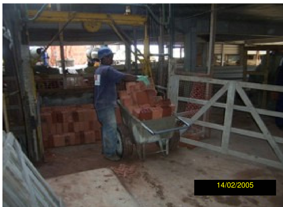
Figura 5.1: Transporte de blocos em jericas
