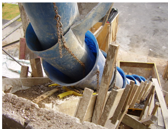
Figura 5.4: Resíduo-duto utilizado em canteiro de obras
