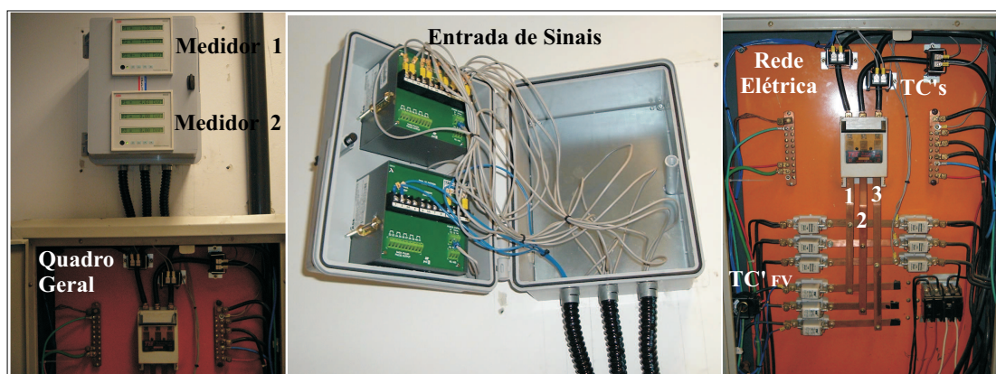
Figura 4.25: Etapas da instalação dos equipamentos utilizados no processo de medição das grandezas elétricas.
