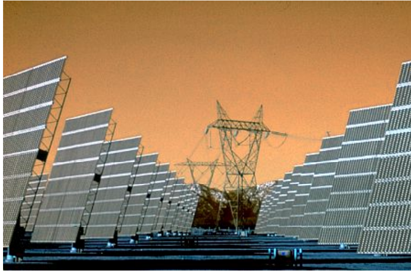
Figura 1.2: Primeiro sistema fotovoltaico centralizado.
