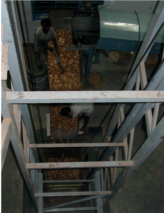
Figura 25. Sistema de alimentação do gaseificador
