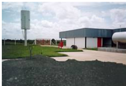
Figura 23 – Usina termoeletrica a carvão, instalada no norte de Minas Gerais
