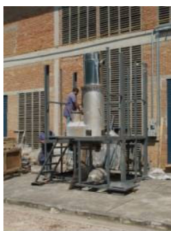
Figura 39 - Posicionamento do corpo do gaseificador sobre a base da estrutura metálica
