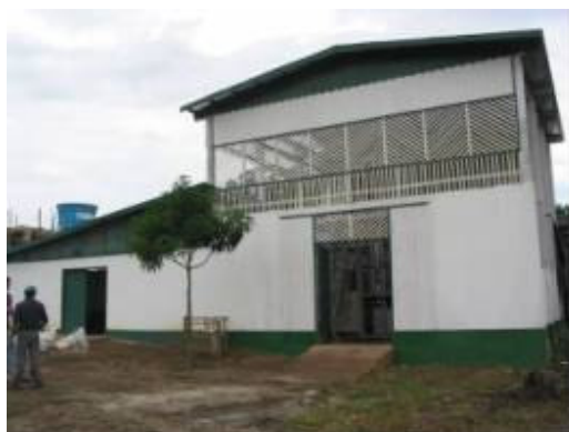
Figura 45 – Abrigo para o sistema de gaseificação construído pelos moradores da comunidade
