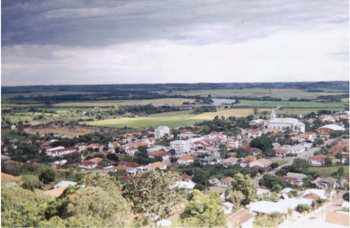
Ilustração 7: Vista panorâmica de área urbana e rural em normais condições. Fonte: Trabalho de campo, 2004.
