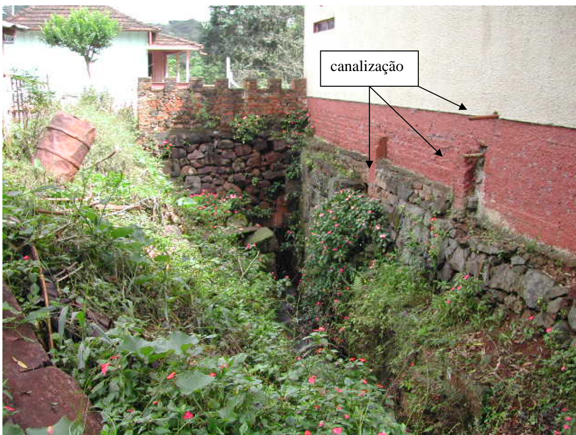
FIGURA 3 - Dejetos domésticos e sanitários canalizados diretamente para o curso do Lajeado da Represa. Pesquisa de campo, Nov/2004. Org. TÁPIA, B.T.
