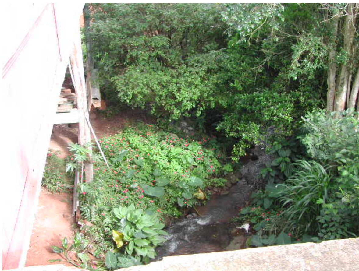
FIGURA 7 - Residência atingida por alagamentos. Pesquisa de campo, Nov/2004. Org. TÁPIA, B.T.
