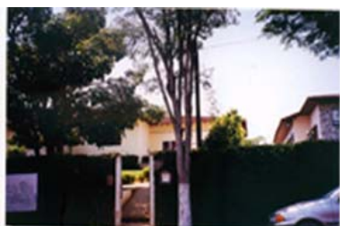
Fotografia 2: Fachada da Escola Sócrates: vista da rua de acesso principal
