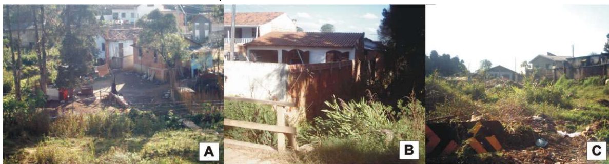
OCUPAÇÕES IRREGULARES SITUADAS NA CABECEIRA DA BACIA - BAIROS ABRANCHES E CACHOEIRA (A) (B) VILA POMPÉIA, (C) VITOR BENATO
