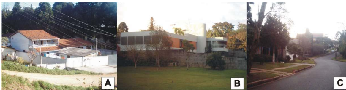
SEGREGAÇÃO SOCIOESPACIAL NA REGIÃO NORTE DA BACIA HIDROGRÁFICA DO RIO BELÉM (ALTO BELÉM) (A) CONSTRUÇÕES NO ABRANCHES E CACHOEIRA; (B) (C) CONSTRUÇÕES NO JARDIM SCHAFFER
