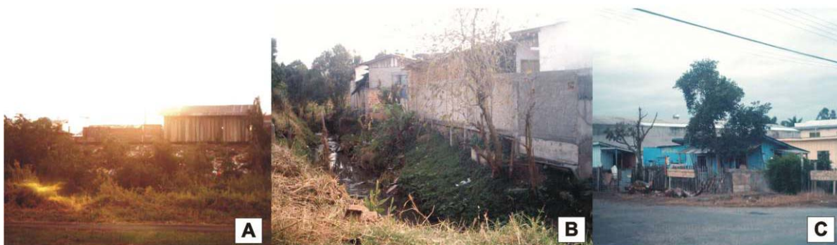
OCUPAÇÕES IRREGULARES DA JUSANTE DA BACIA - BAIRRO BOQUEIRÃO (A) PARQUE NÁUTICO, (B) SANTA RITA DE CÁSSIA, (C) CIDADANIA
