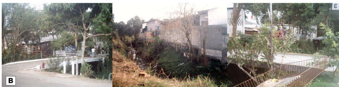
(B) LOTES LEGALIZADOS, MAS COM CONSTRUÇÕES IRREGULARES - SEM APROVAÇÃO DA PMC - COM EDIFICAÇÕES LOCALIZADAS NAS MARGENS DOS CORPOS D'ÁGUA E/OU NAS ÁREAS DEFINIDAS PELO IPPUC E PMC COMO INUNDÁVEIS
