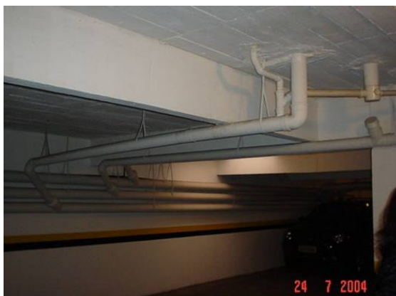
FIGURA 4.18 – SUB-COLETORES DE ESGOTO SANITÁRIO DO EDIFÍCIO
