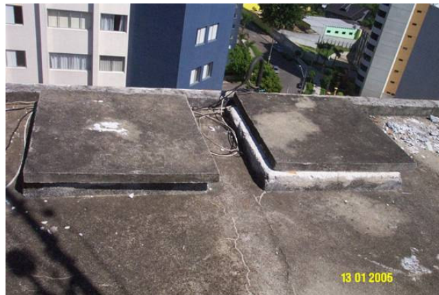
FIGURA 4.15 – TAMPA DE ACESSO DO RESERVATÓRIO SUPERIOR
