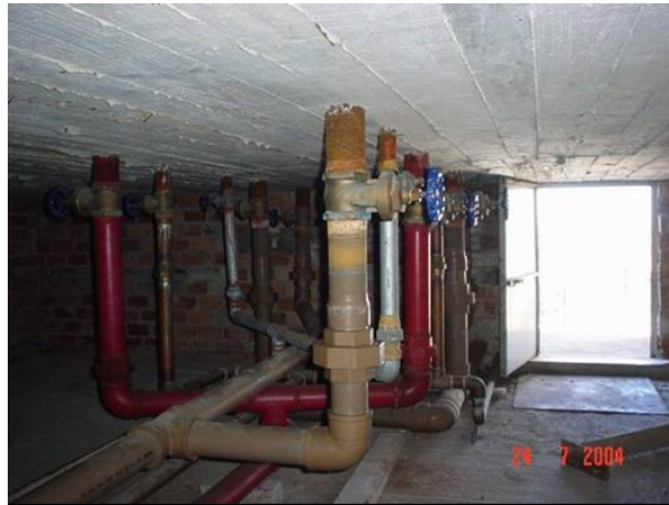
FIGURA 4.16 – BARRILETE DE DISTRIBUIÇÃO
