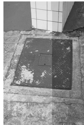
b) Caixa subterrânea para hidrômetro padrão SANEPAR
