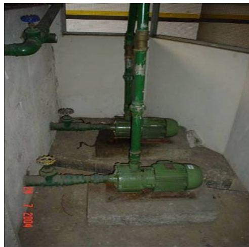
FIGURA 4.14 – CONJUNTO MOTOR-BOMBA DE RECALQUE
