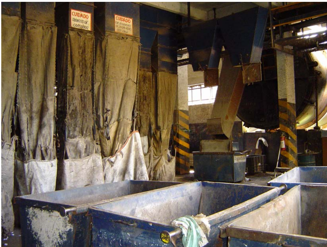
Foto 3: Canais de comunicação entre os pavimentos.
