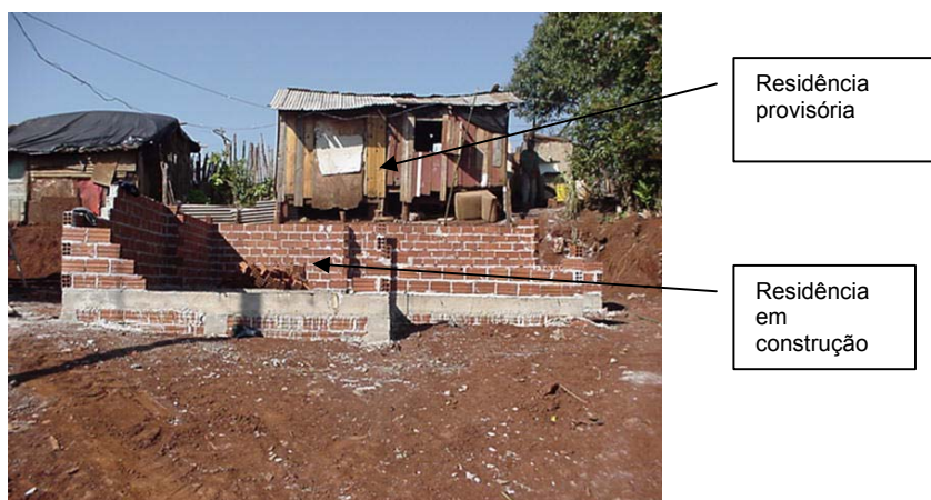
FIGURA 4.3 -CASA EM CONSTRUÇÃO COM HABITAÇÃO PROVISÓRIA
