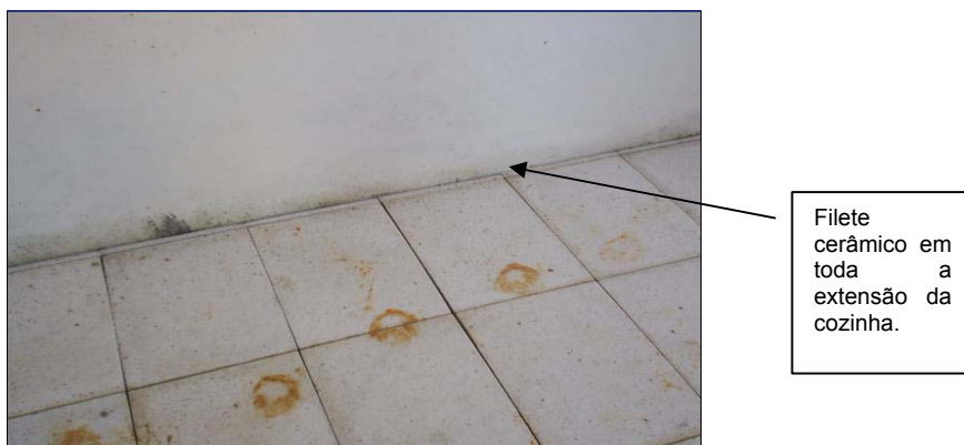
FIGURA 4.34 - FILETE DO PISO AO LADO DA PAREDE
