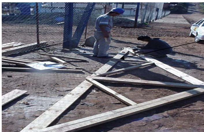
FIGURA 4.28 - FORNECIMENTO DA MADEIRA PARA CONFEÇÃO TESOURAS
