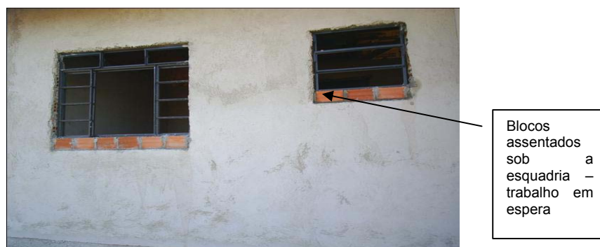
FIGURA 4.24 - PREENCHIMENTO BLOCOS APÓS COLOCAÇÃO ESQUADRIA
