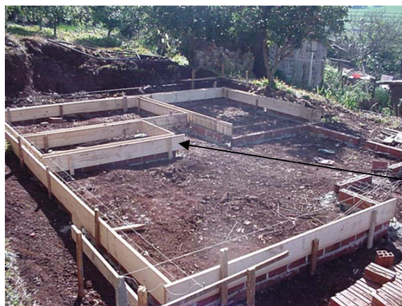
FIGURA 4.18 - VISUALIZAÇÃO DAS VIGAS BALDRAME
