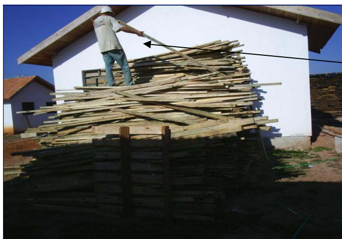
FIGURA 4.29 - FORNECIMENTO DA MADEIRA A GRANEL
