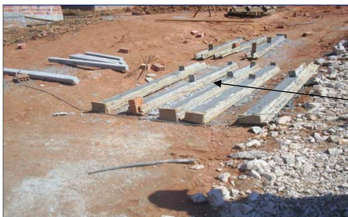
FIGURA 4.21 - CONCRETAGEM DAS VERGAS NO CANTEIRO
