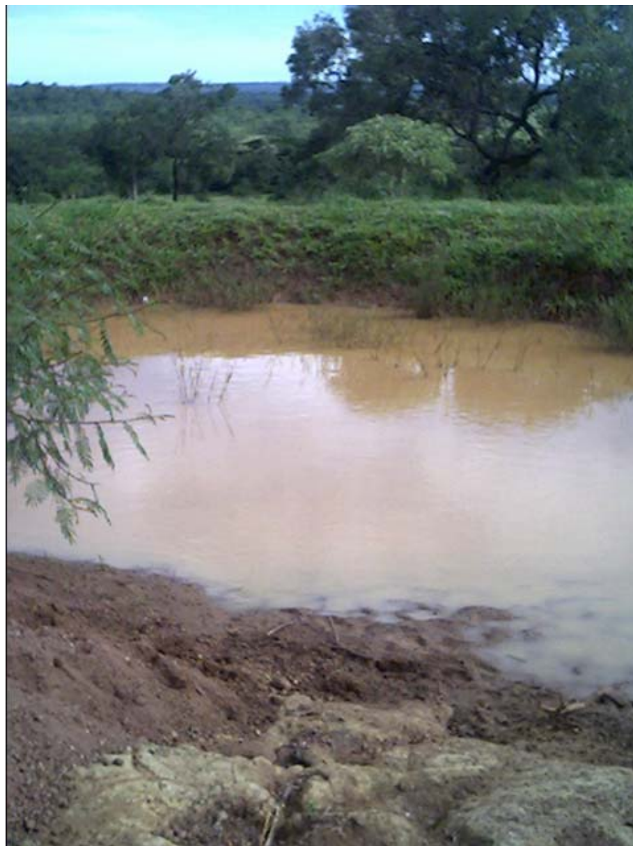
Foto 7 - Bolsão de contenção da água da chuva, cuja finalidade deveria ser a de facilitar a infiltração de água da chuva.
