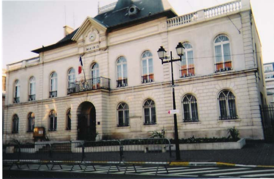
Figura 1 – Ação do governo francês em locais públicos relacionado ao plano vigipirate . Barreiras instaladas em frente à Prefeitura de Bourg-La-Reine/França (2003)
