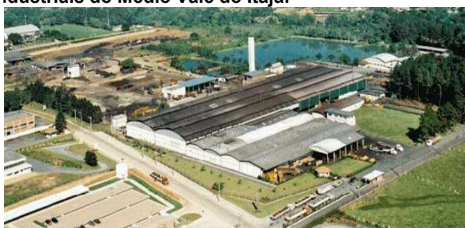
Metisa, Distrito Industrial de Timbó - SC
