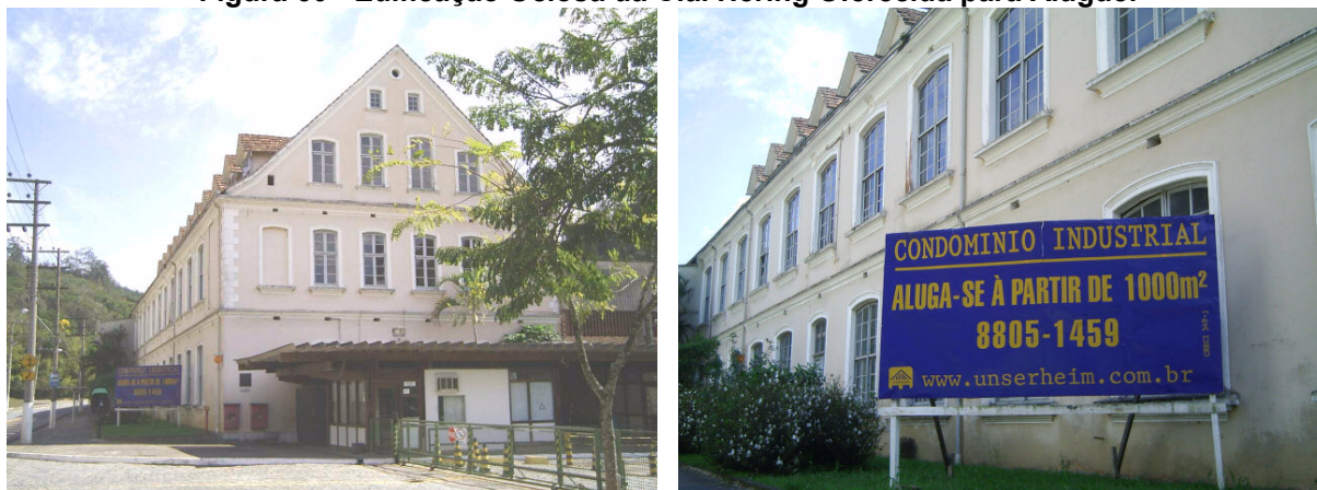
Figura 60 - Edificação Ociosa da Cia. Hering Oferecida para Aluguel
