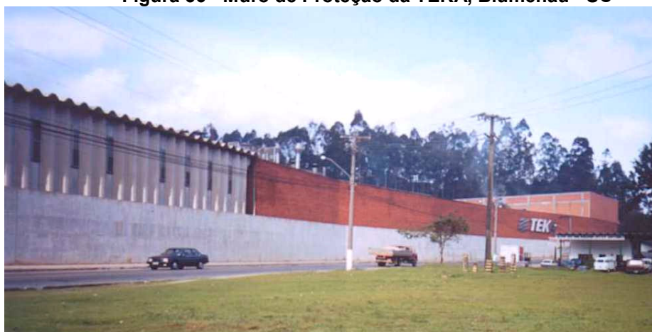
Figura 56 - Muro de Proteção da TEKA, Blumenau - SC
