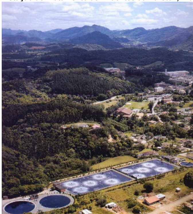
Figura 57 - Estação de Tratamento de Efluentes da Karsten, Blumenau - SC
