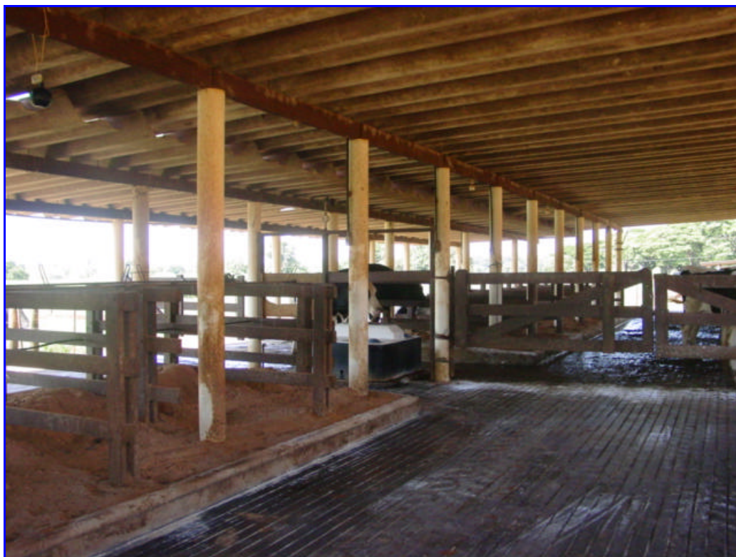
Figura 5 – Detalhe do piso de cimento rugoso
