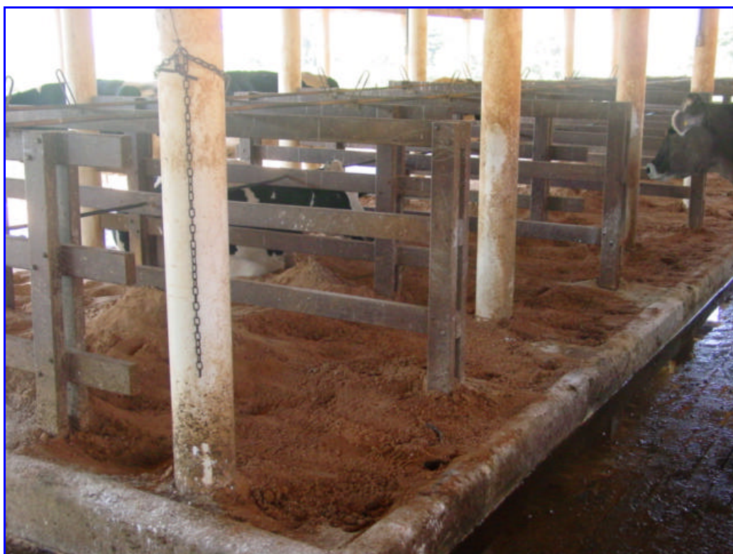
Figura 3 – Baias do free-stall construídas com madeira e com cama de areia
