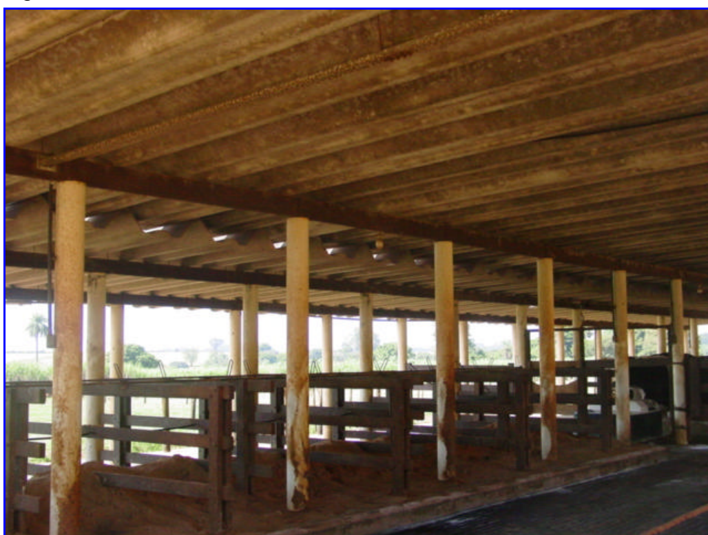
Figura 2 – Vista interna do free-stall
