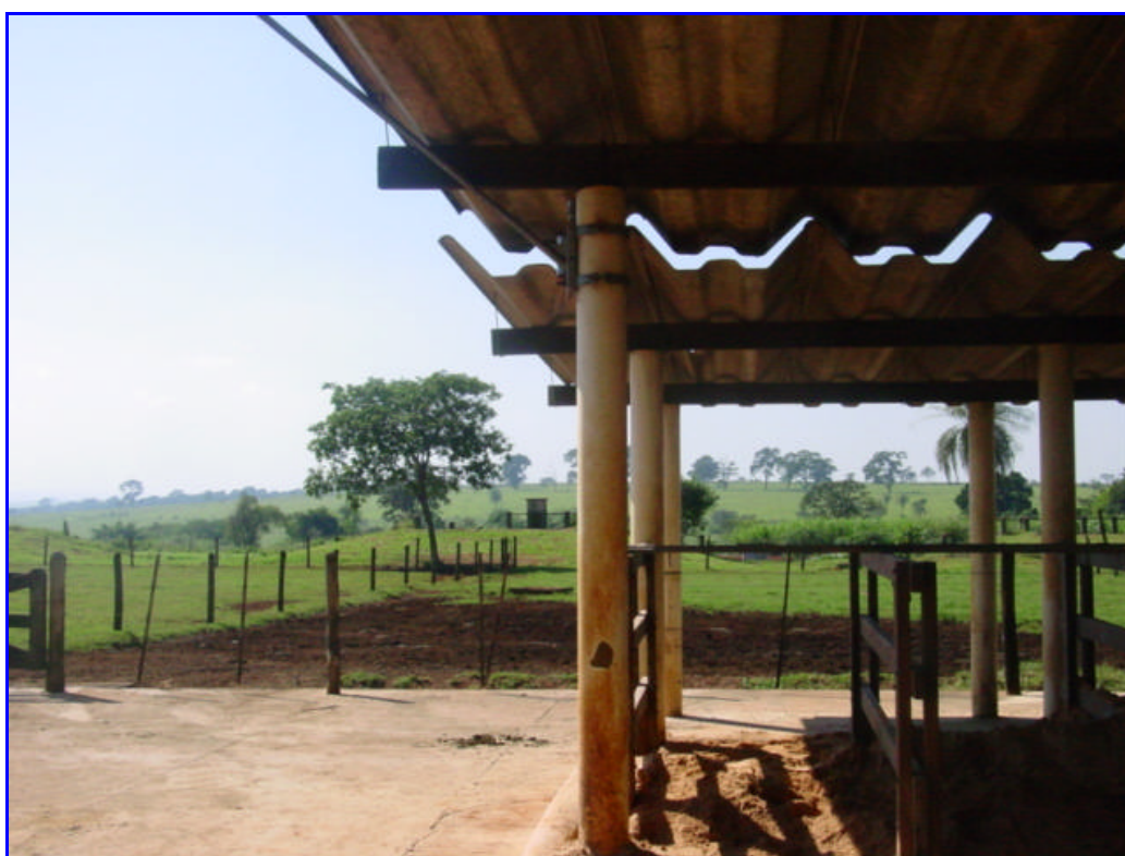
Figura 4 – Vista do piquete adjacente ao free-stall
