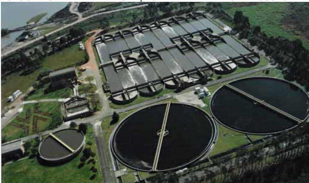
FOTO 3 –VISTA AÉREA DA ESTAÇÃO DE TRATAMENTO DE ESGOTO BELÉM
