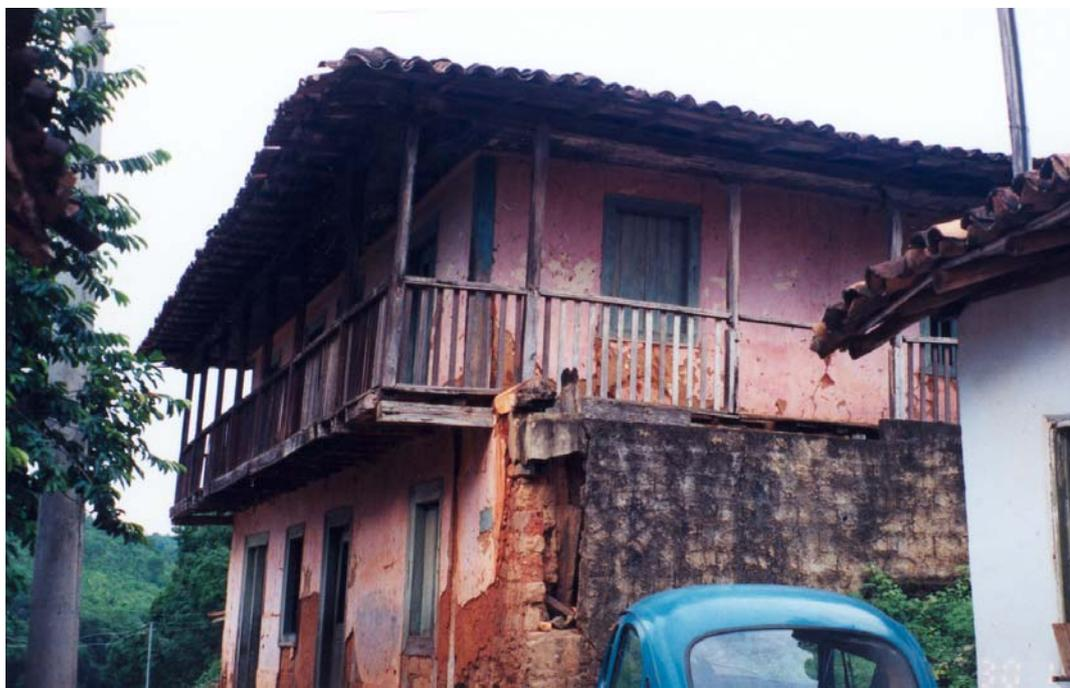
**FIGURA 63** - Casa do Inconfidente Domingos de Abreu Vieira. Fachada lateral esquerda. Detalhe do avarandado que circula o 1º pavimento, com acabamentos em madeira e réguas simples de madeira no guarda-corpo
