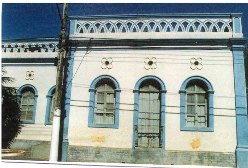
**FIGURA 108 e 109** - Platibandas de edificações no município de Januária, MG
