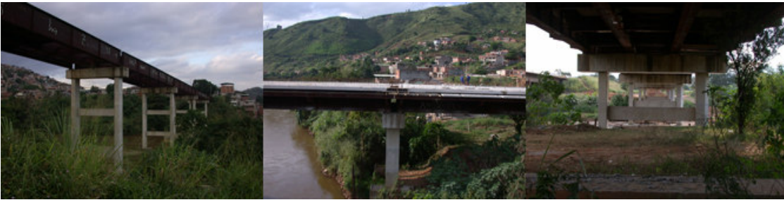
FIGURA 03 – Imagens de infraestruturas viárias (viadutos) em construção no novo trecho do anel rodoviário da BR-381 em Coronel Fabriciano.
