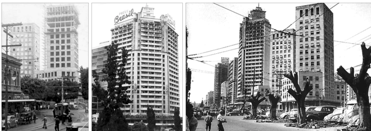
FIGURA 21 – Imagens do edifício Sulacap-Sudameris e entorno: o Ed. Sulacap visto a partir da rua da Bahia; o Ed. Acaiaca no centro, e, à direita, na década de 60, após a derrubada das árvores da Avenida Afonso Pena.
