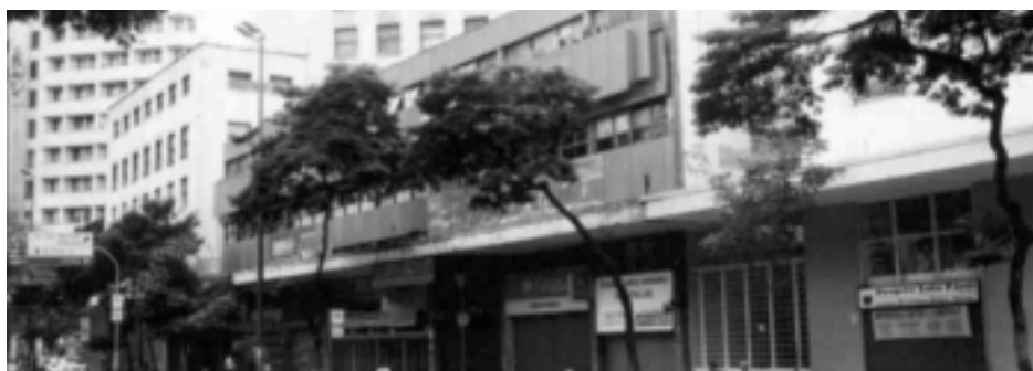
FIGURA 23 – Anexo construído em frente ao edifício Sulacap-Sudameris.
