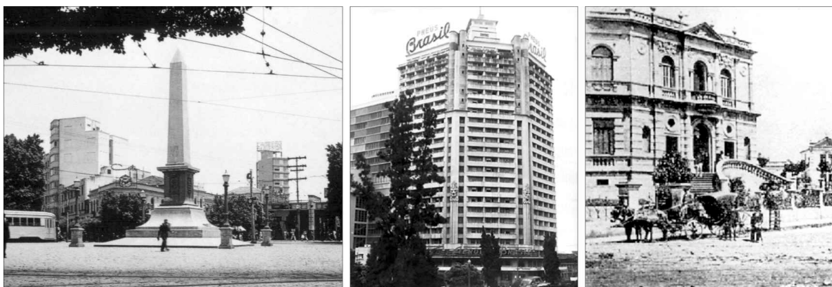
FIGURA 3 – O obelisco da Praça Sete, o edifício Acaiaca e o prédio neocolonial da antiga Faculdade de Direito, já demolido.
