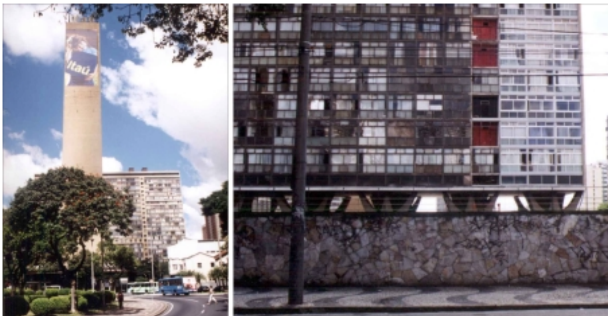
FIGURA 26 – Foto recente do JK e do início de restauração da fachada.
