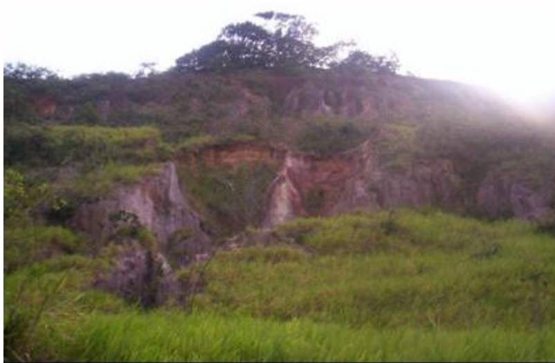
Figura 19 – EROSÃO EM RAVINAS NA BORDA DA MATA
